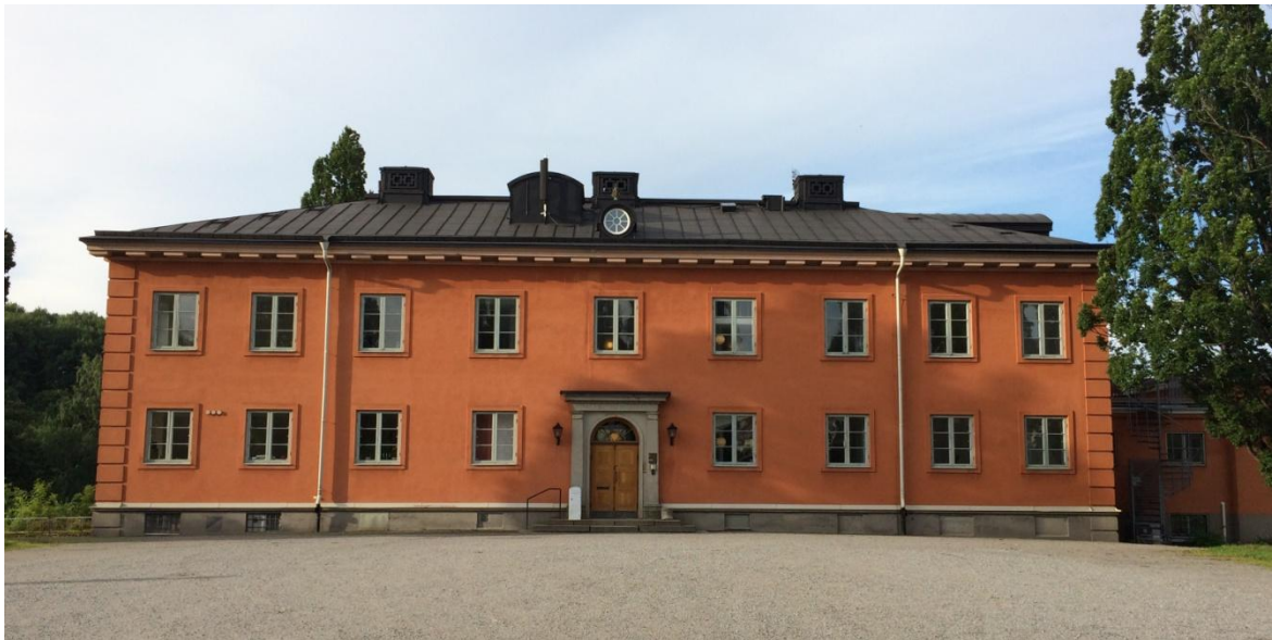
Statens Växtskyddsanstalts huvudbyggnad uppfördes 1930 i enkel och stram 1920-tals klassicism med en portal av kalksten som mittpunkt. Foto: Michael Karlsson.
